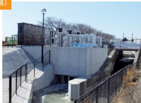
大井川用水（志太幹線）の落差工を利用した、伊太発電所に続く新たな小水力発電所です。
