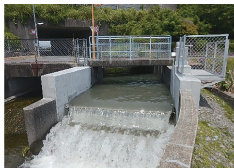
施工後 自動転倒ゲート
