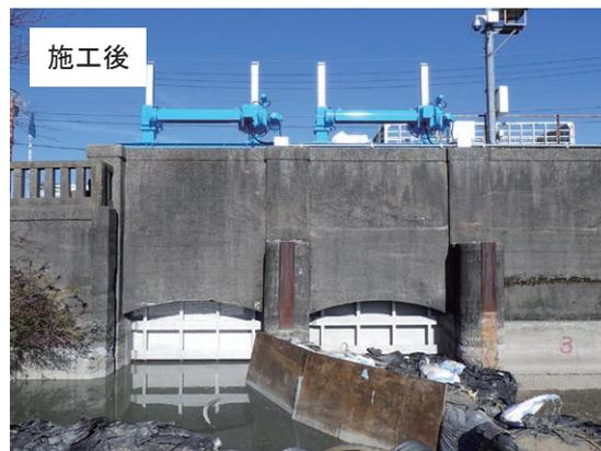
島田市道悦にある栃山川の起点となる水門です。老朽化が著しいため、県営事業にて設備の更新と水に浸かる部分の門柱や擁壁を補修し延命化を図りました。
