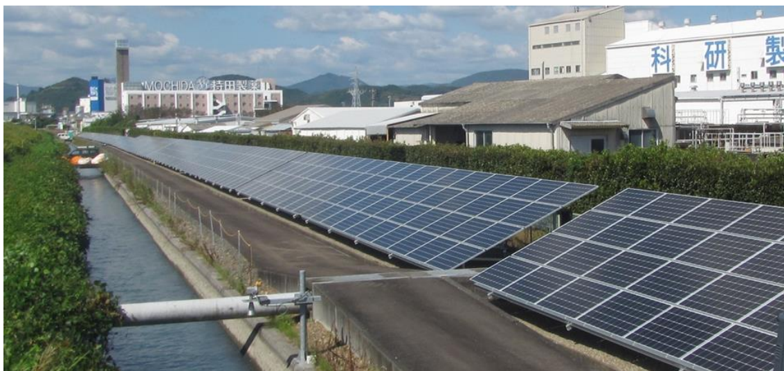
《建設現場の下流から上流を望む》
