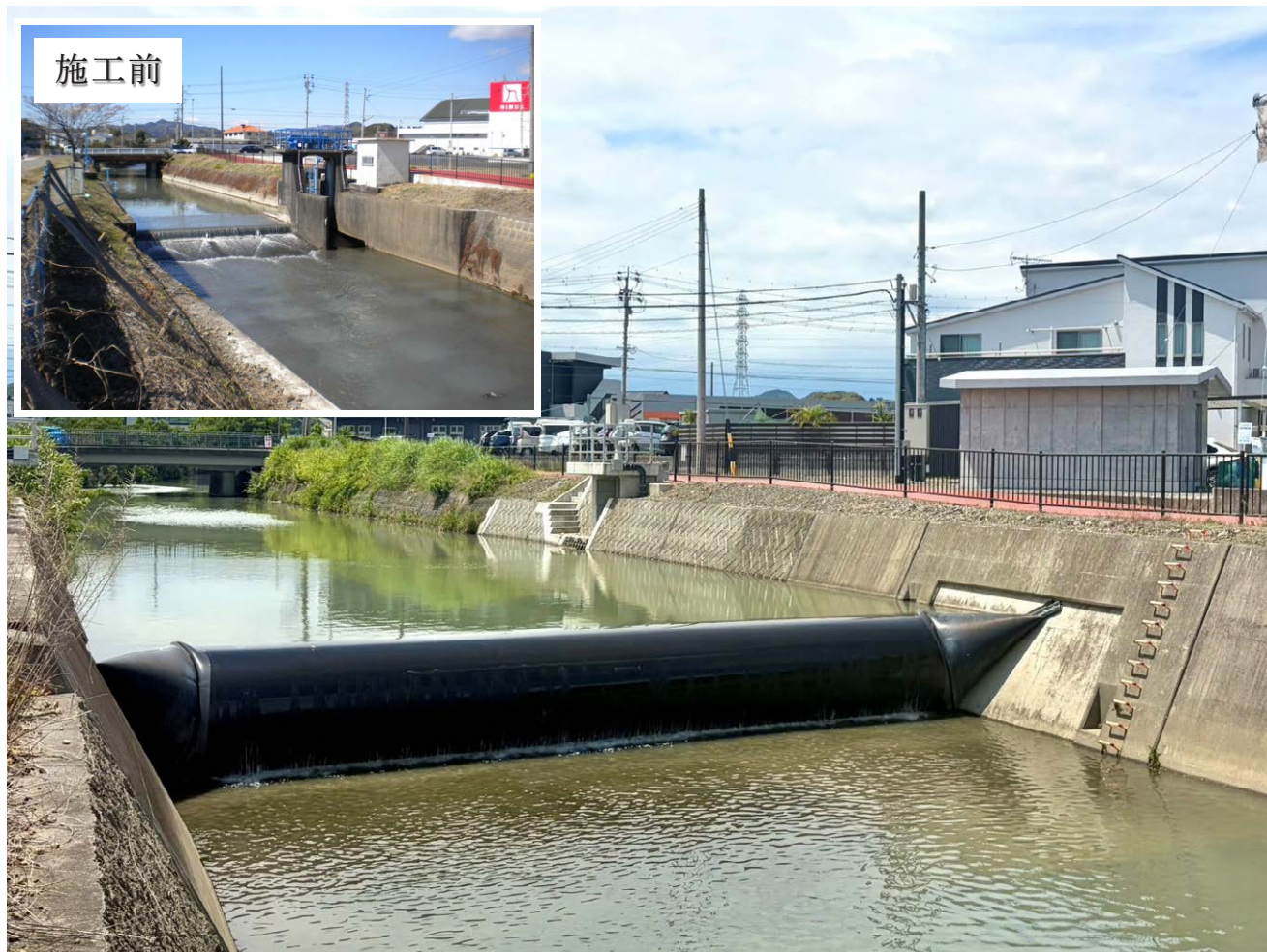
青木頭首工(下流側)
